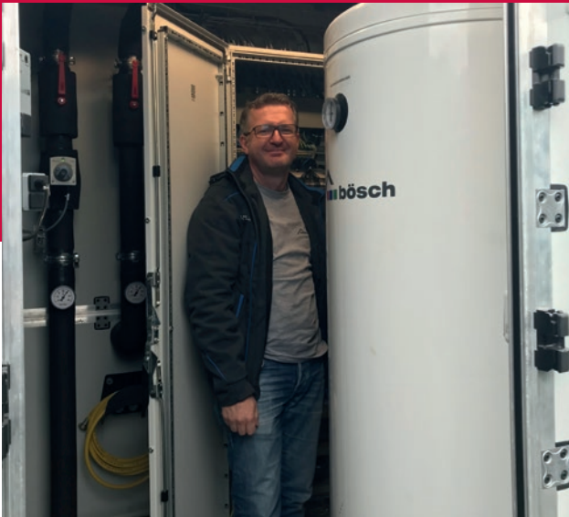
bösch Projekttechniker Johann Unger bei der Inbetriebnahme im Technikraum inklusive Schaltschrank, Warmwasser-Boiler, Puffer für Heizung und Kälteversorgung.
