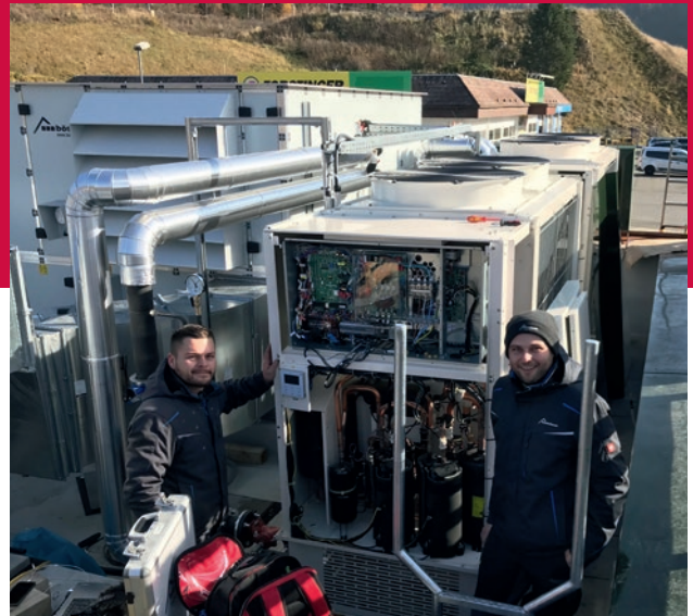
Die beiden bösch Kundendiensttechniker Marcel Mikusch (links) und Julian Schöffauer (rechts) bei der Inbetriebnahme der Clivet WSA-N-YES Wärmepumpen und des Samsung Klimagerätes von bösch.
