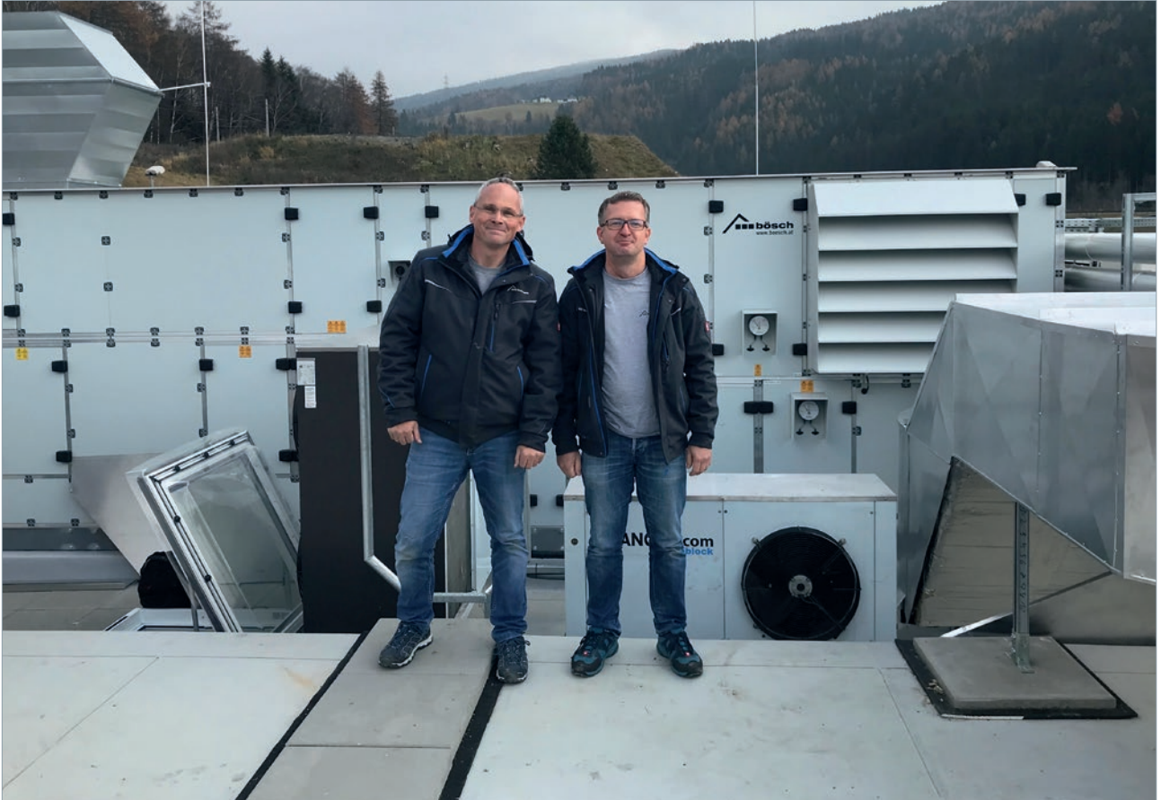
Günther Kurz (bösch SYGA Projektverkauf) mit Johann Unger (bösch Projekttechniker) bei der Einweisung und Anlagenübergabe.
